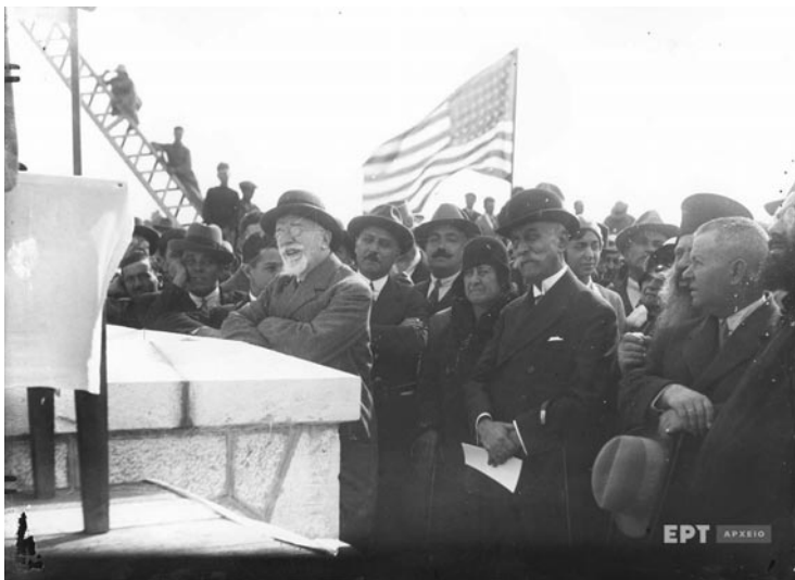
Εγκαίνια του φράγματος της λίμνης του Μαραθώνα. Ο πρόεδρος της Δημοκρατίας Παύλος Κουντουριώτης, ο πρωθυπουργός Ελευθέριος Βενιζέλος και ο αρχιεπίσκοπος Χρυσόστομος διακρίνονται ανάμεσα στο πλήθος πάνω στο φράγμα της λίμνης. (25/10/1929) (0000001696 / 1.1.18.3)
